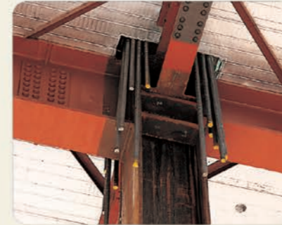
④ 기둥주위 보강 ANGLE 설치
