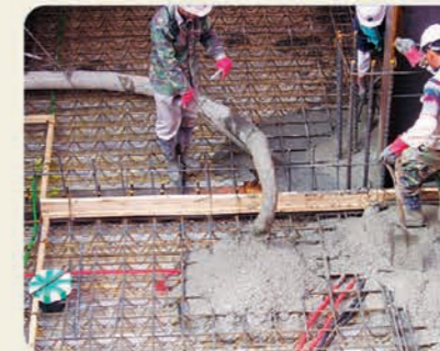
⑩ 콘크리트 타설
