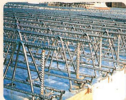
4 슈퍼데크 설치 완료
