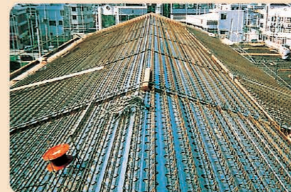
● 경사지붕 설치 (부천 송내 대우APT)
