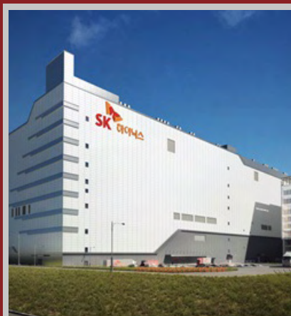
삼성물산 | SK하이닉스 반도체 공장
